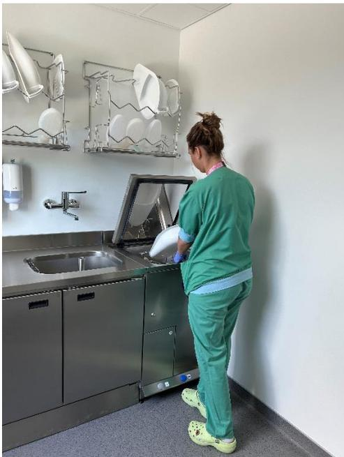
*Figure 1: Salle Utility d'un hôpital équipé d'un lave-bassins et de mobilier en Inox sur mesure. Introduction du bassin de lit et mise en route par pédale.*
